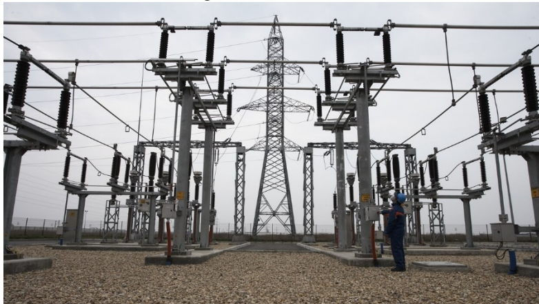
Figura 2. Stație de transformare
