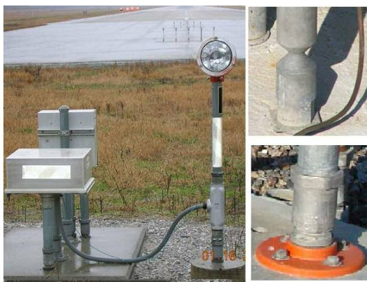
Fig. 1. Exemple de cuplaje frangibile
