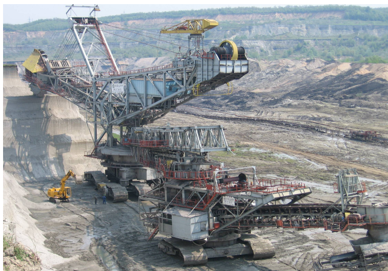
Fig. 1. Vedere de ansamblu a excavatorului cu rotor EsRc-1400
