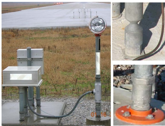
Fig. 1. Exemple de cuplaje frangibile
