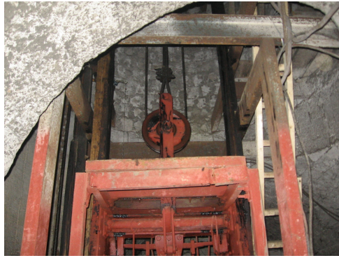
Fig. 3. Modul de fixare a cablului contragreutății [2]
