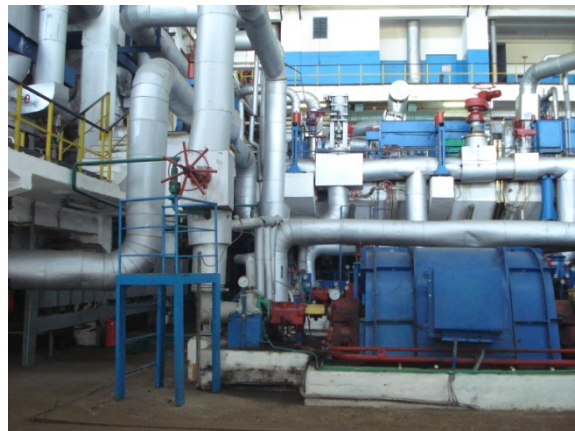
Fig. 2 Sistemul de control termic al motorului TIS 1500/1100-4-2
