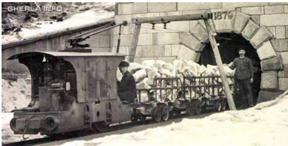
Fig.2. Metodă de transport din subteran la suprafață la salina Ocna Dej
