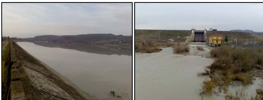
Fig.4. Vedere generală a barajului hidrotehnic Pucioasa
