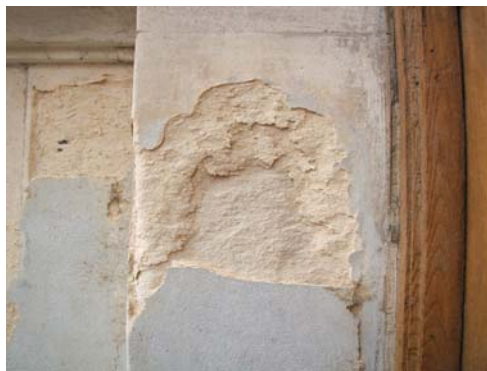
Fig.1 Exfolieri masive in exteriorul cladirii
