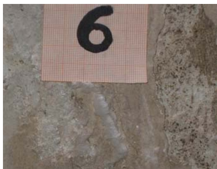
Fig.4 Proba nr.6, eflorescenta de saruri pe finisaje si tencuiala
