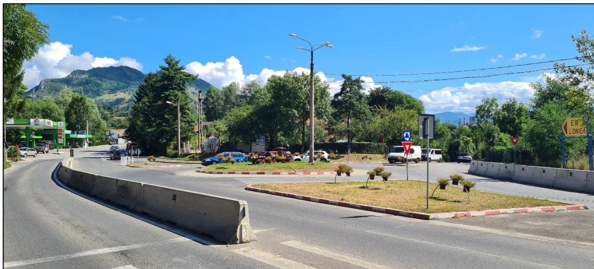
Fig. 4.1. Giratoriul Dărănești – imagine intersecție
