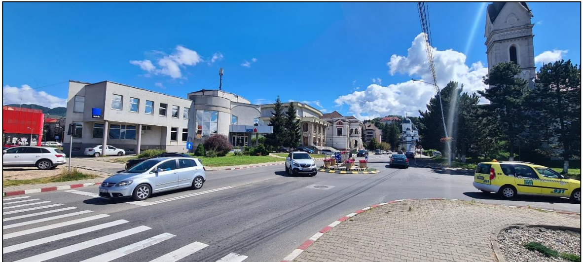
Fig. 4.7. Giratoriul Banca BCR – imagine intersecție
